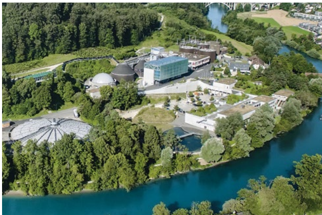
L'impianto di depurazione delle acque bernese arabern produce biogas naturemade star dal 2009. (Foto: arabern)
