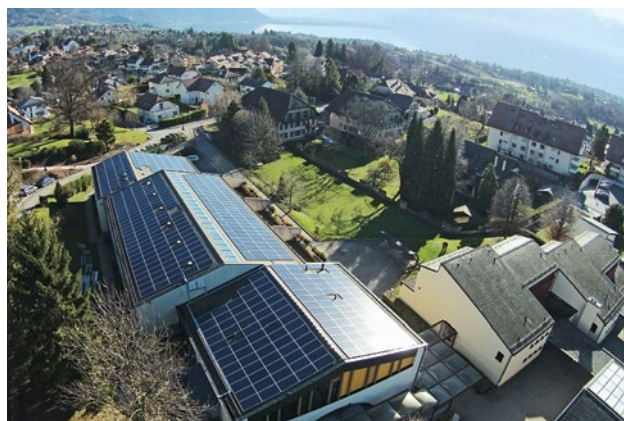
Sul tetto del Collège Clos Béguin a St-Légier, la Rochat Solaire SA, in collaborazione con il comune di St-Légier, produce dal 2015 elettricità naturemade star. (Foto: Rochat Solaire SA)
