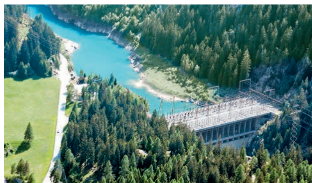
L'azienda elettrica Hinterrhein AG ha concluso gli interventi prescritti, volti a risanare i deflussi residuali. (Foto della centrale Bärenburg, certificata naturemade basic: azienda elettrica Hinterrhein AG)
