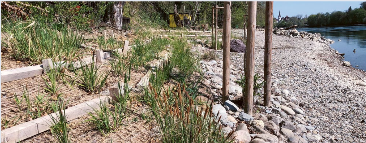
Des nattes en fibre de coco et en laine de mouton plantées de plantes indigènes, d'alpiste faux-roseau et de diverses espèces de laïche, constituent une protection des rives proche de l'état naturel (photo: SH Power).
