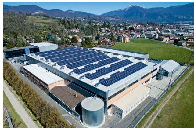
Mise en service 2015: installation photovoltaïque certifiée naturemade star des fournisseurs d'énergie Azienda Elettrica Ticinese et Aziende Municipalizzate di Stabio à Stabio TI. (Photo: AET)
