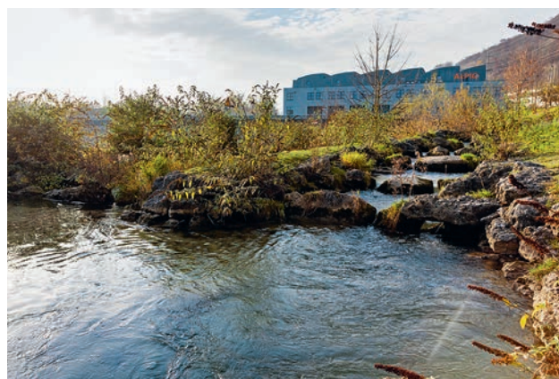
Cours d'eau de contournement de la centrale de Ruppoldingen d'Alpiq Hydro Aare AG. (Photo: Alessandro Della Bella)
