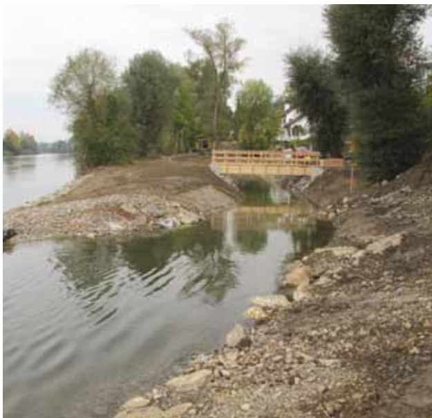
Wiederbelebung von altem Flussarm und Altwasser (Binzerliweiher in Oetwil a.d.L.), ewz
