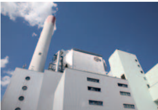
Zertifizierte Kehrrechtverwertungsanlage Basel
