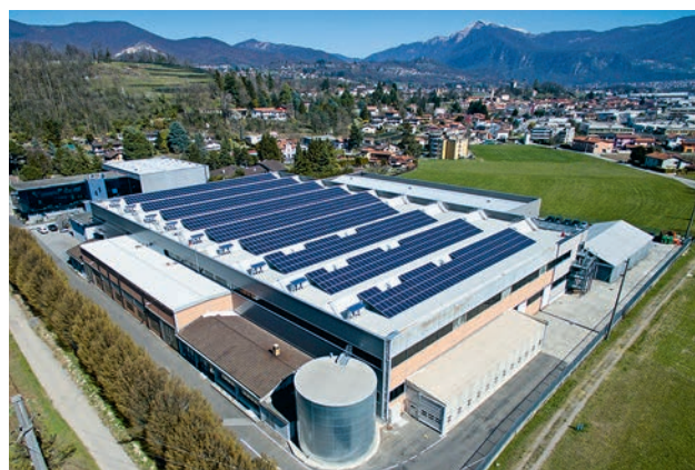
2015 in Betrieb genommen: naturemade star Photovoltaik-Anlage der Energieversorger Azienda Elettrica Ticinese und Aziende Municipalizzate di Stabio in Stabio TI. (Foto: AET)
